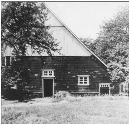
Abbildung 12: Die verschieferte östliche Giebelseite mit Eingangstür (Mitte) und Stalltür (rechts) um 1930. (Foto im Familienbesitz)
