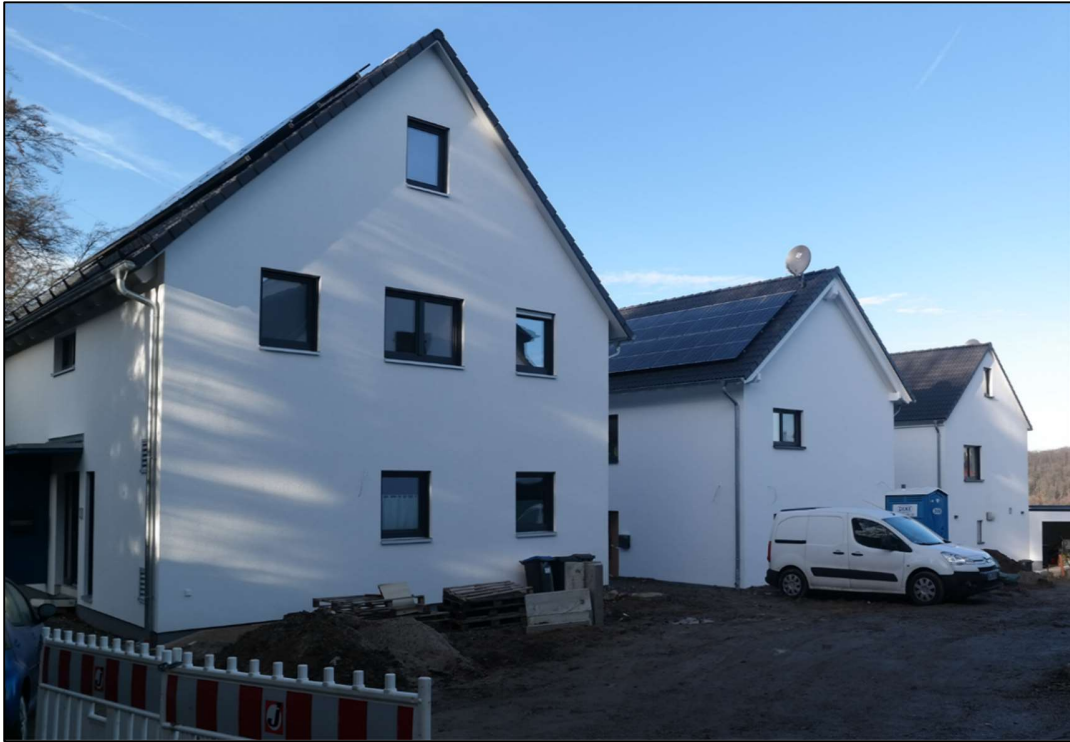
Abbildung 19: Gesamtansicht der drei neuen Häuser im Jahr 2020 © Wolfgang Hebel 2020
